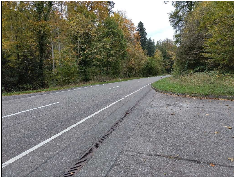
Abbildung 5: Entwässerungsrinne an der Zufahrt zum Portal Würmtalrampe
