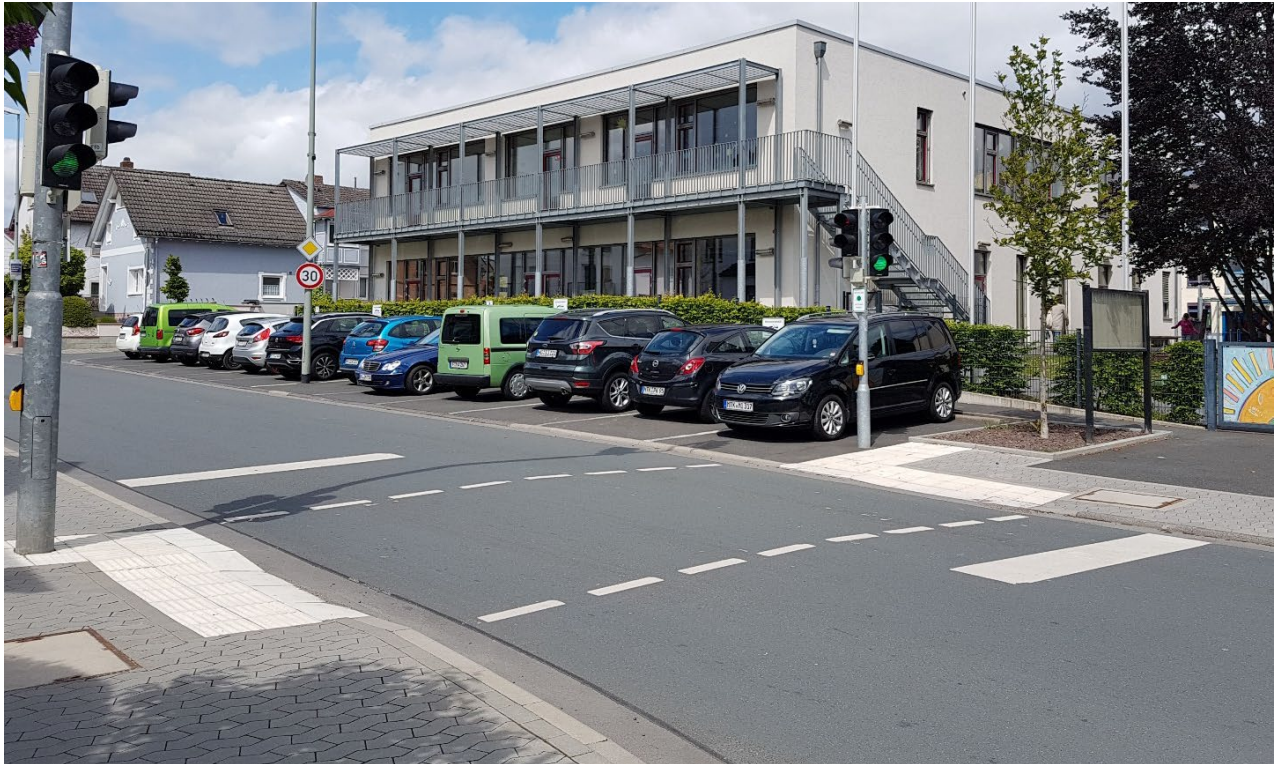
Abbildung 68 Beispiel Barrierefreier Überweg in Bad Soden (Quelle: eigenes Foto)
