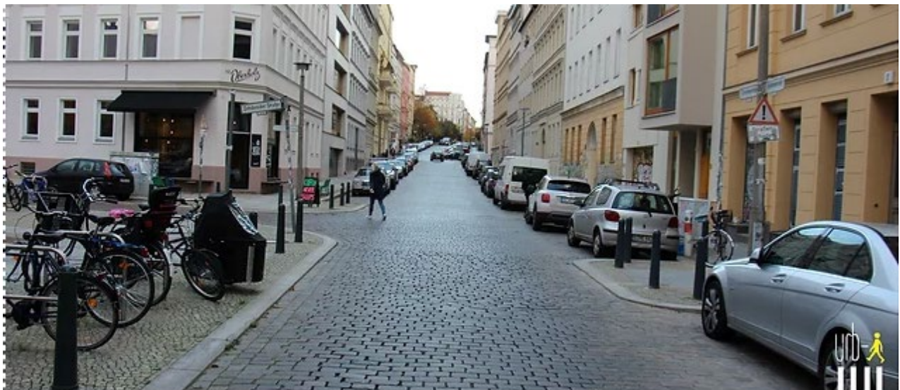
Abbildung 71 Beispiel Umgestalteter Knotenpunkt in Berlin (Quelle: URB-I, 2016)
