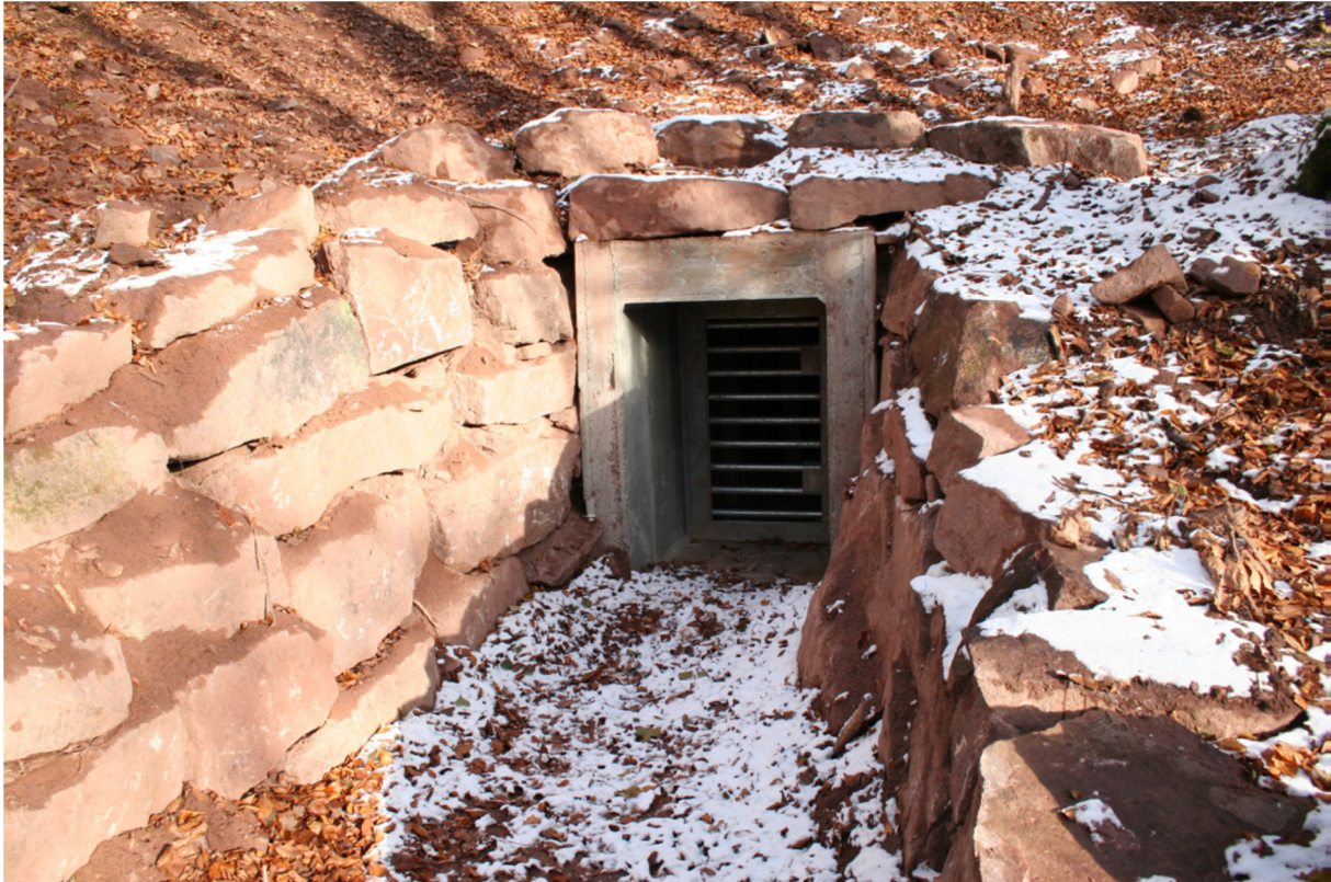
Fledermausgerecht sanierter Stollenzugang im Würmtal (Foto: Bauer)
