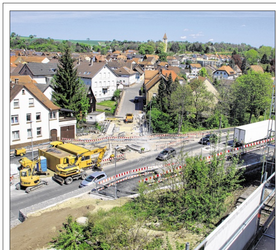
FÜR DIE BELAGSARBEITEN („Flüsterasphalt“) muss die Landesstraße 570 in Königsbach vom 9. bis 13. Mai gesperrt werden. Foto: Faulhaber
