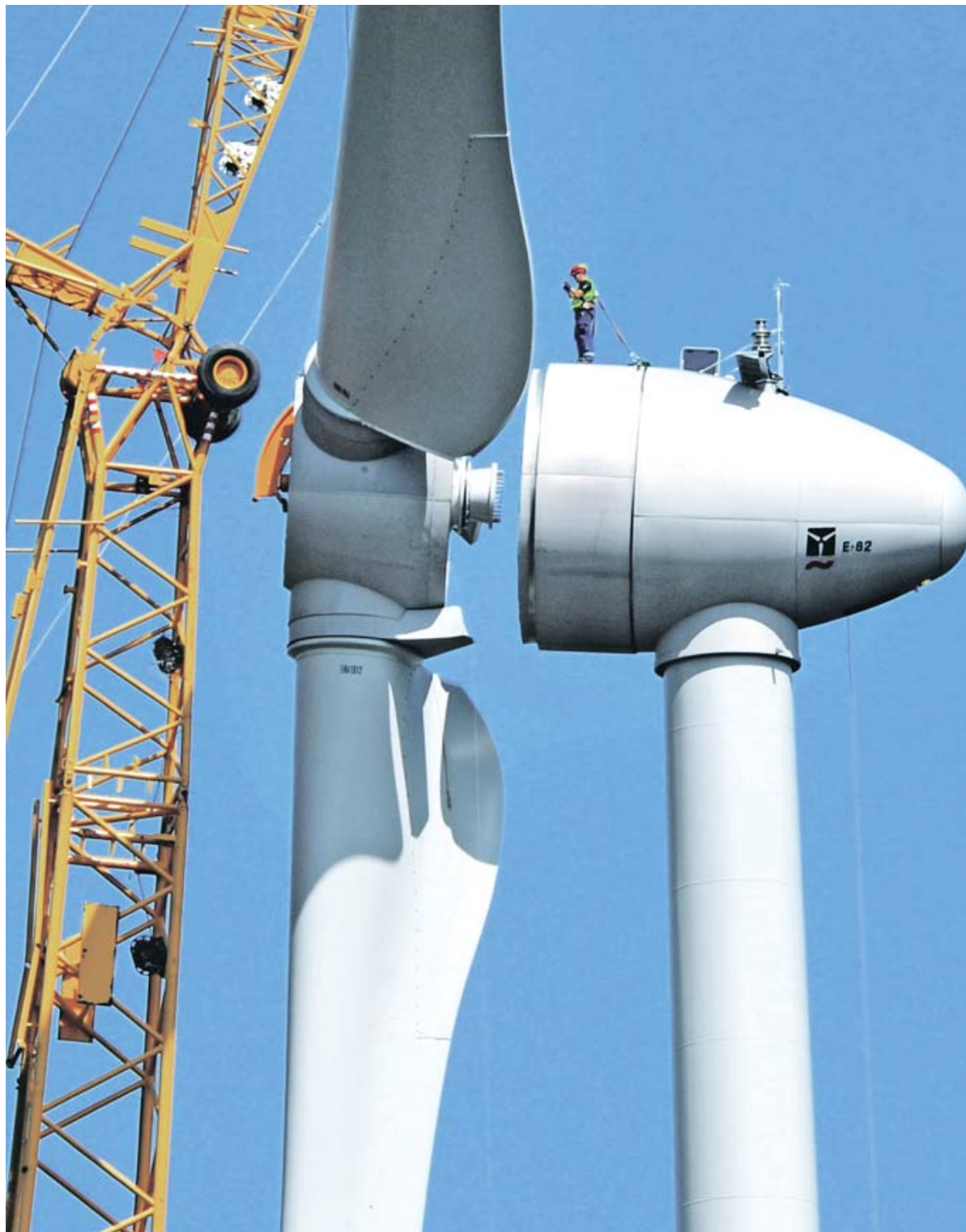
Beim Bau neuer Windkraftanlagen hinkt Baden-Württemberg hinterher. Das soll sich auch im Nordschwarzwald ändern. Um die Rahmenbedingungen wird aber noch heftig gerungen. FOTO: HAID, ARCHIV
