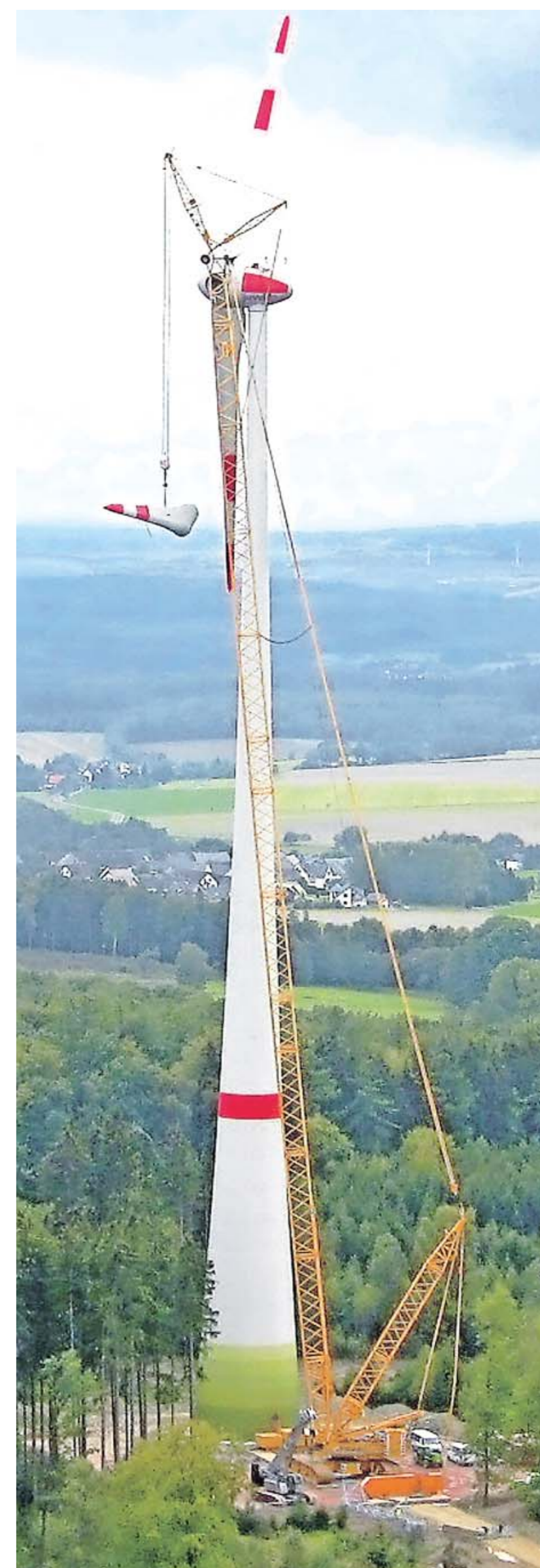
Viel zu tun: Hier wird im Hunsrück ein Enercon-Windrad aufgebaut, dessen Nabe 138 Meter hoch ist. Im Nordschwarzwald wird noch kaum Windkraft genutzt. FOTO: ENERCON
