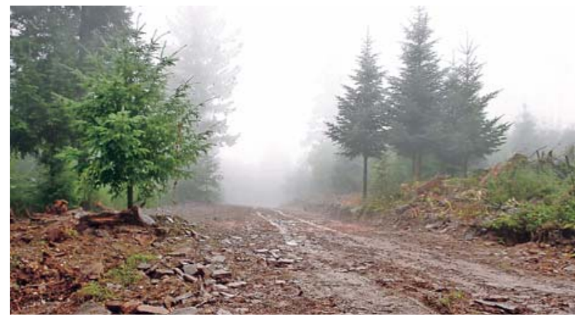
Rodung auf dem „Köpfle“: Die Vorarbeiten für einen Windmess-Masten seien ausdrücklich keine Festlegung in Richtung Windpark, ehe die Bürger abgestimmt haben. Bei einem „Nein“ müsse der Projektentwickler wieder aufforsten. FOTO: KETTERL
