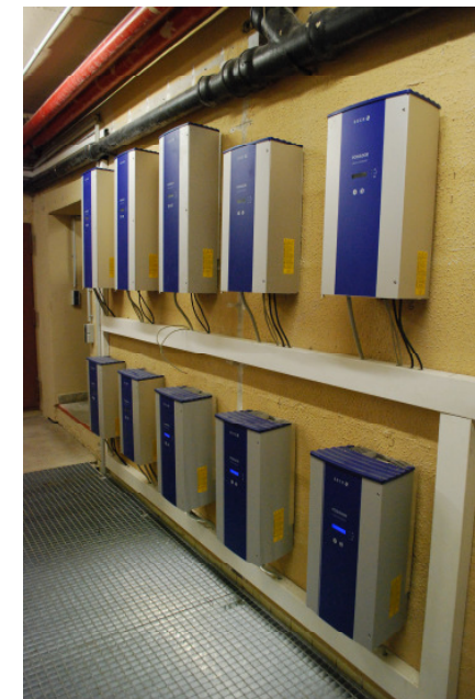
Wechselrichter
