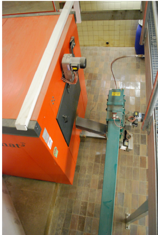
Pelletheizkessel
