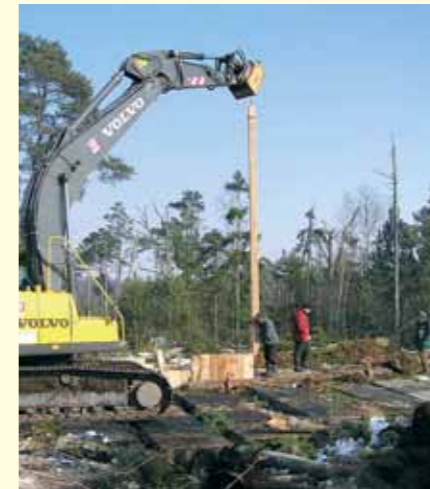
Bau der Spundwand im Dornacher Ried, Landkreis Ravensburg.
