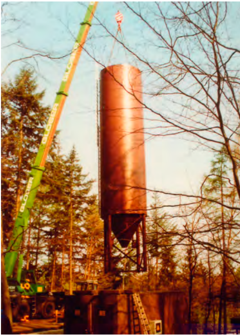
In dem in den 80er Jahren errichteten Silo wurde Flugasche aus Kohlekraftwerken mit Zement gemischt. Das Gemisch brauchte man zum Wiederfüllen der alten Erzgänge in der Grube Käfersteige.
