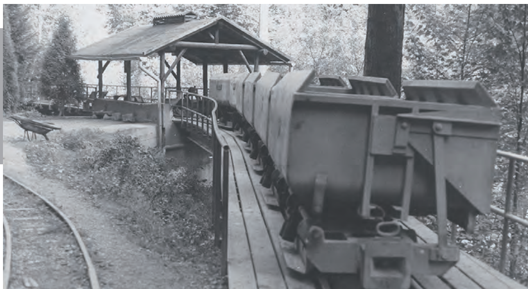
Bis zur Fertigstellung der Würmtal-Rampe (1989) erfolgte der Abtransport des Rohaufwerks mit Bergwerksloren.
