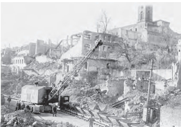
Zur Trümmerbeseitigung wurde in Pforzheim eine „Trümmerbahn“ eingesetzt. Auch das Pforzheimer Fluß- und Schwerspatwerk beteiligte sich bis zur Aufnahme des Grubenbetriebs (1951) an der Trümmerbeseitigung.
