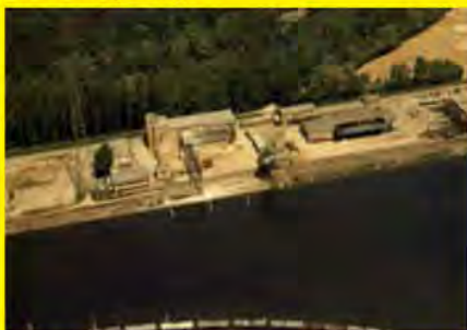
Die Aufbereitungsanlage im Karlsruher Rheinhafen
