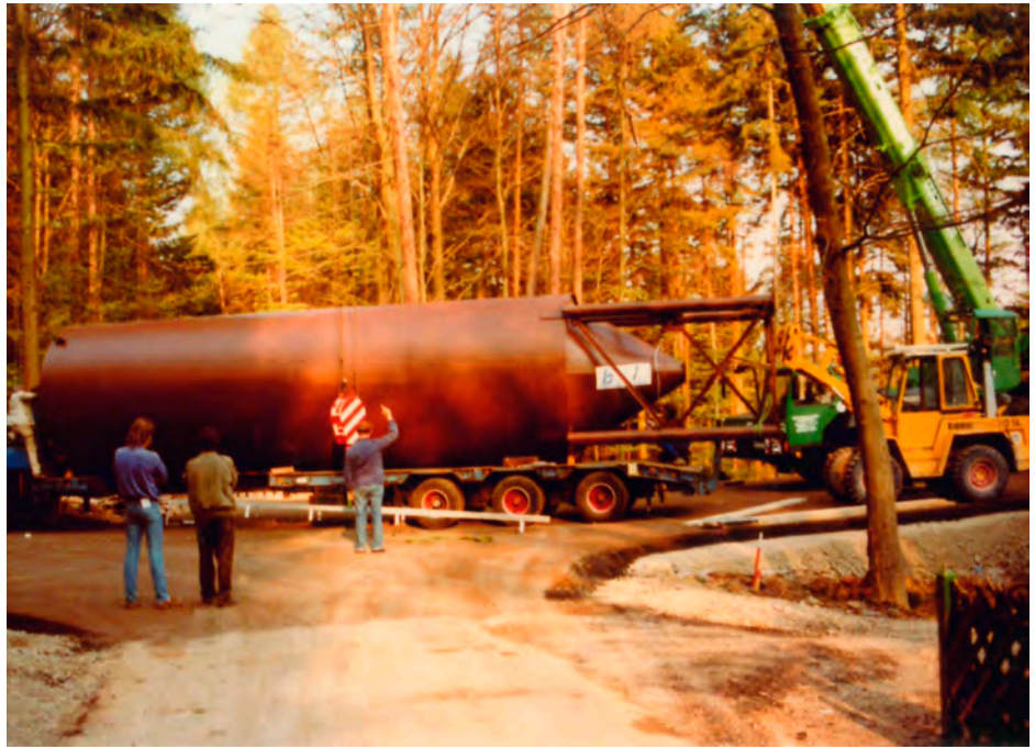
In dem in den 80er Jahren errichteten Silo wurde Flugasche aus Kohlekraftwerken mit Zement gemischt. Das Gemisch brauchte man zum Wiederfüllen der alten Erzgänge in der Grube Käfersteige.
