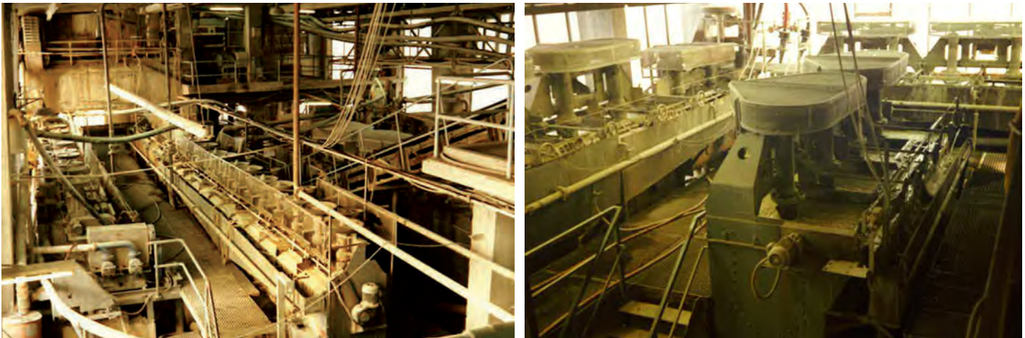
Die gemahlene Flußspatmasse blieb an den großen Walzen hängen und wurde dann abgeschabt.
