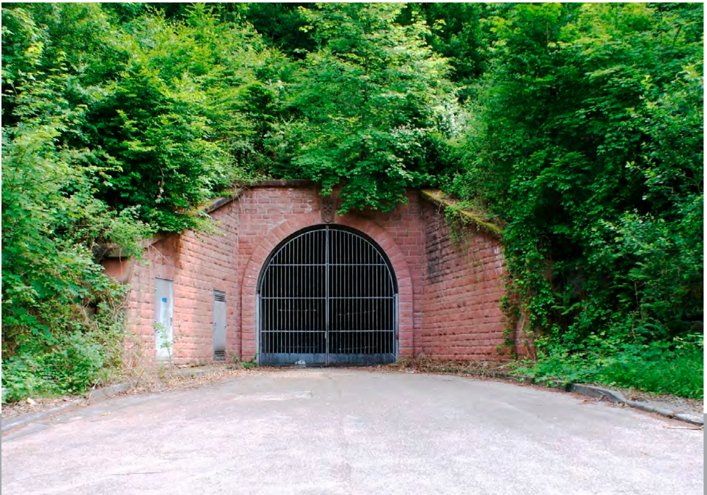
Der Stolleneingang zur Würmtalrampe befindet sich (heute noch) an der Würmtalstraße (erbaut 1989).
