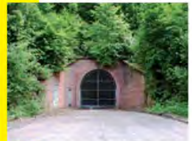
Würmtalrampe mit neuem Stolleneingang seit 1991 an der Würmtal-Straße
