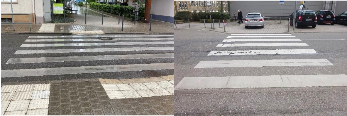
Abbildung 43: Vergleich barrierefreier / nicht barrierefreier Fußgängerüberweg in Pforzheim
