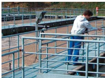
Arbeiten am Belebungsbecken
