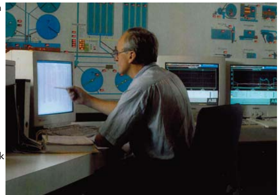
In der Leitwarte
