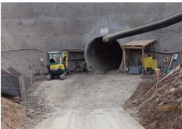
Gewerbegebiet Buchbusch: Vortriebsarbeiten am Abwasserstollen
