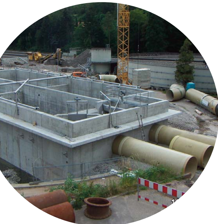
2011: Neubau eines Beckens
