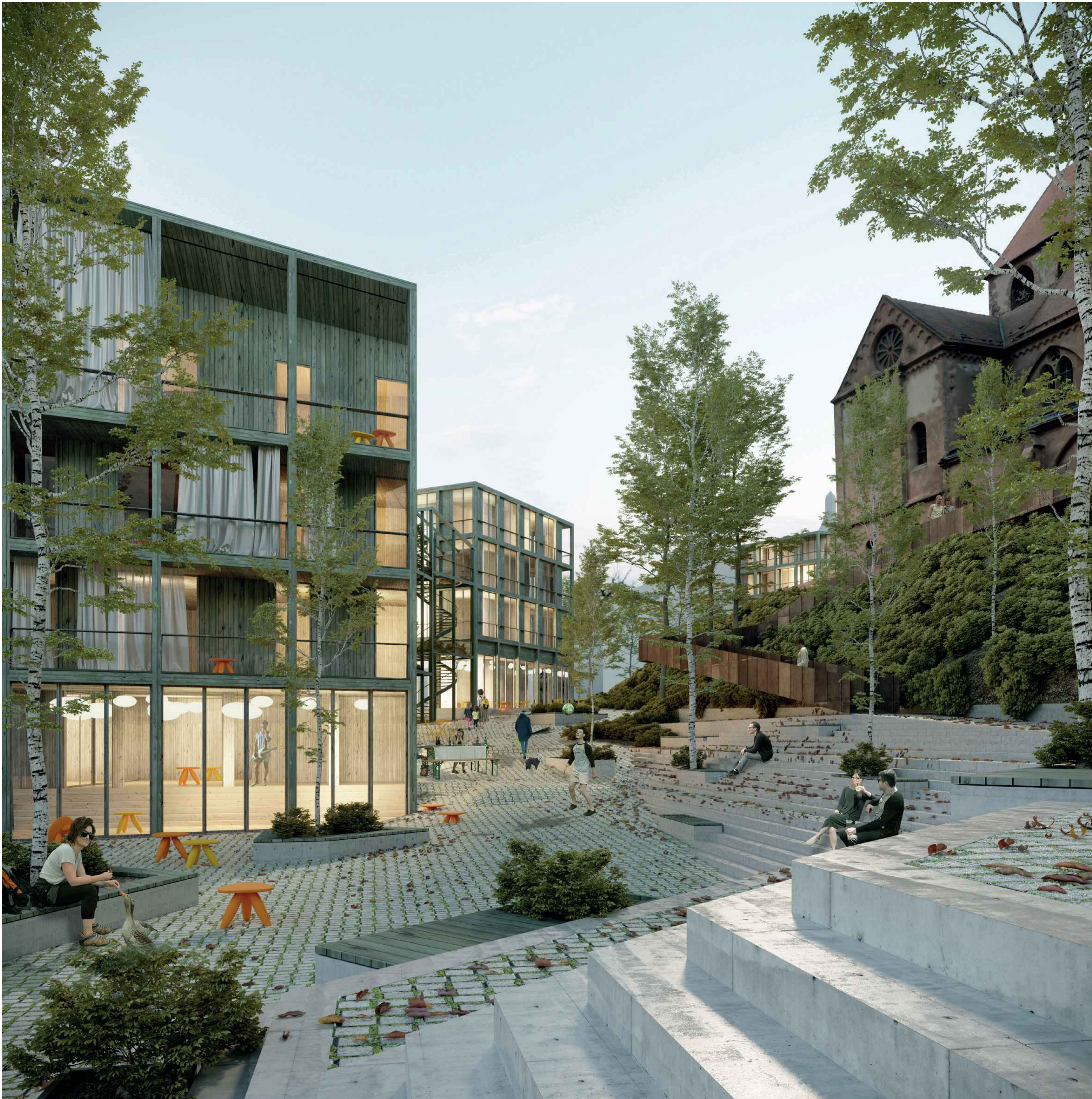
Blick auf den Freiraum zwischen Kirche und Neubau
