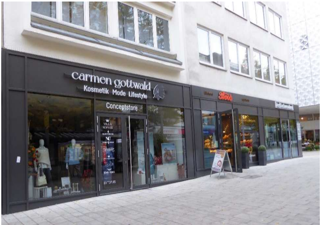
Abbildung 22: Fassadenförderprogramm, Westliche Karl-Friedrich-Straße 5 und 7
