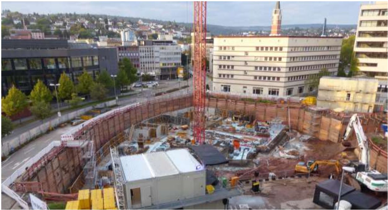
Abbildung 10: Baustelle neues technisches Rathaus
