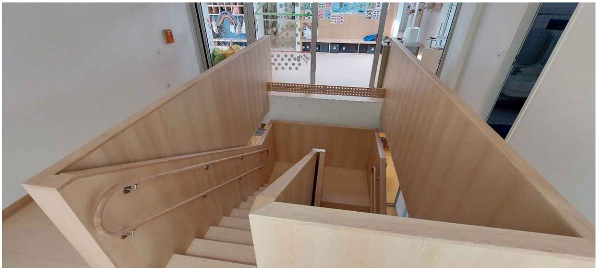
Abb. 25: Kita Friesenstraße, neu gestaltete Treppe Bestand mit Blick in den Neubau Quelle: Gebäudemanagement | Arne Bäuerle
