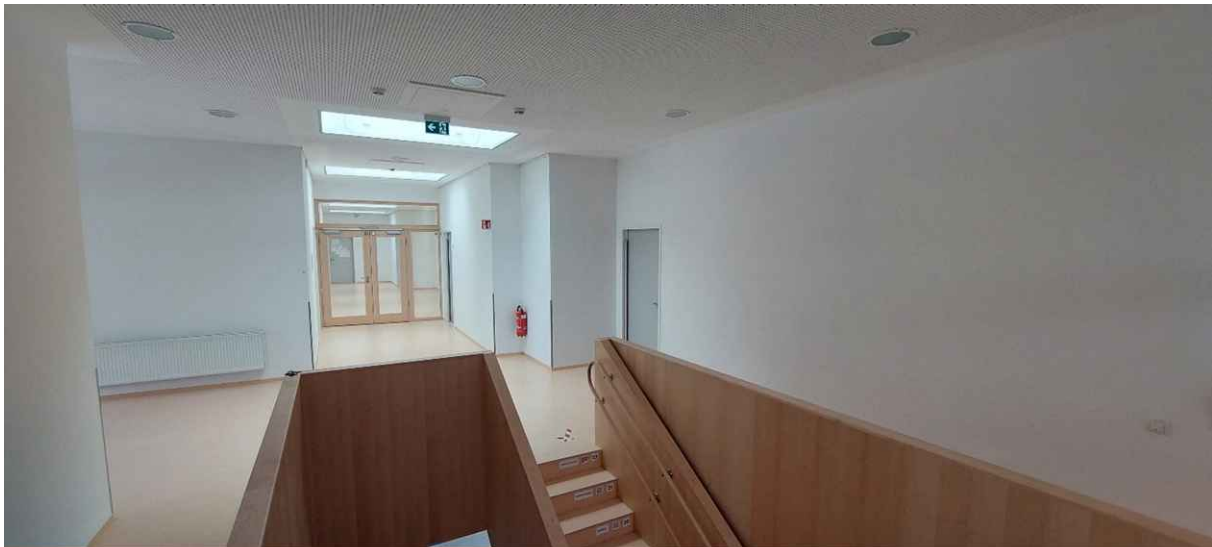
Abb. 26: Kita Friesenstraße, neu gestaltete Treppe Bestand mit Blick in den Neubau Quelle: Gebäudemanagement | Arne Bäuerle
