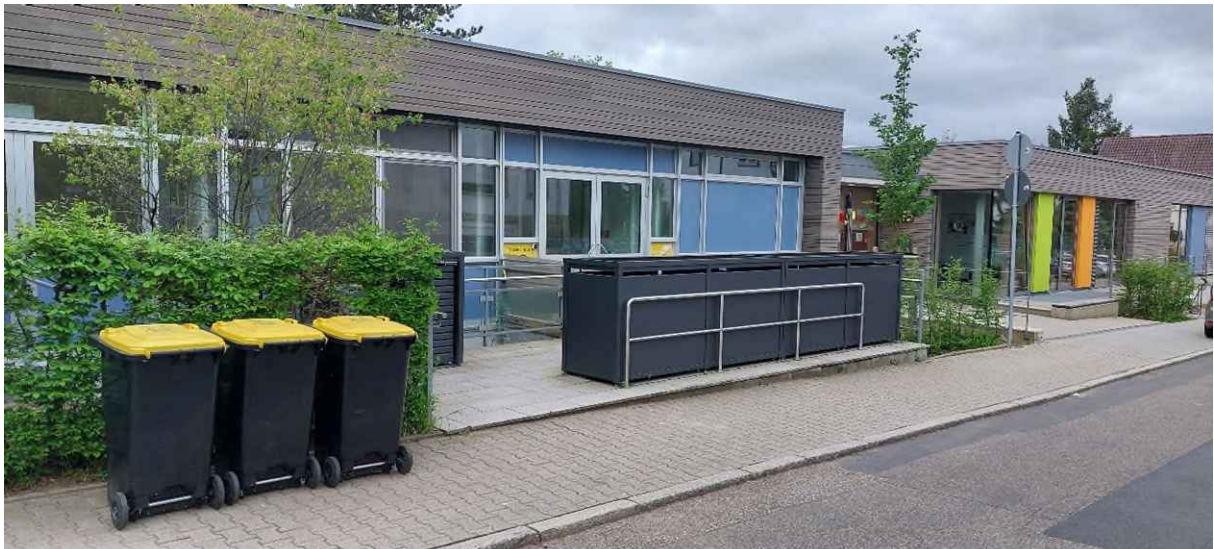
Abb. 23: Kita Friesenstraße, Nordfassade Bestand Quelle: Gebäudemanagement | Arne Bäuerle
