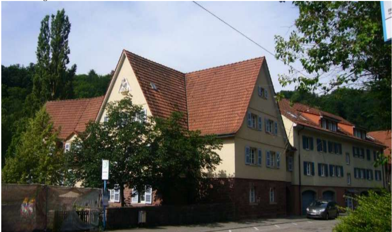
Hirsauer Straße 228 - 244, Flst.Nr. 20220, 20220/2, 20220/3 Wohnanlage, 1922-26
