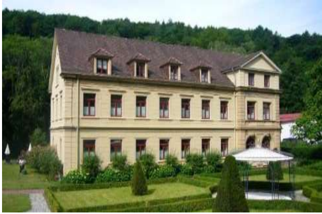
Ehem. Remise (Feuerwehrgerätehaus), 1899
