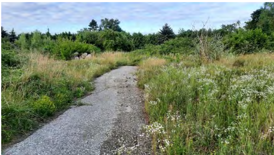
Abb. 6: Das Betriebsgelände des ehemaligen Bauhofs ist stark verbracht und teilweise in einem fortgeschrittenen Sukzessionsstadium
