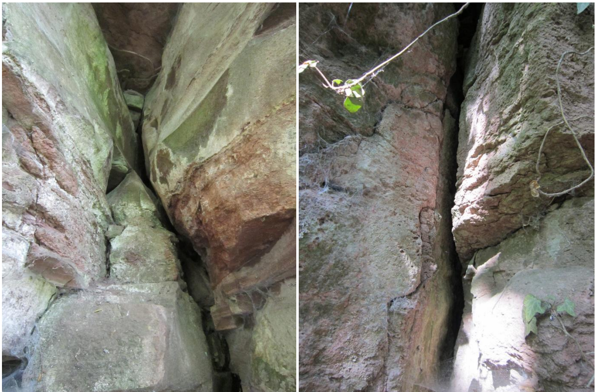
Abbildung 3: Felsspalten im südwestlichen Bereich (links) und im nördlichen Bereich des Steinbruchs (rechts).
