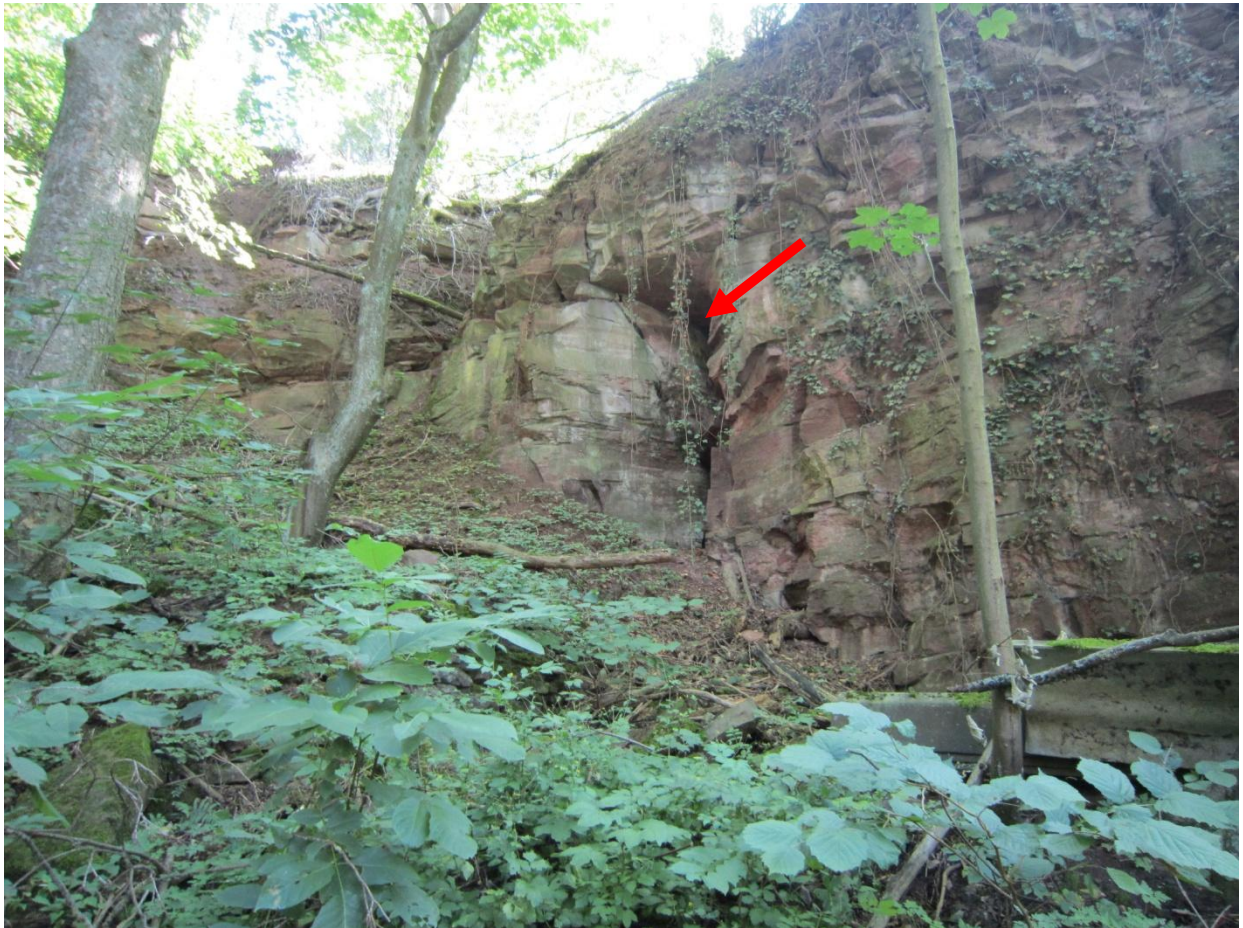
Abbildung 2: Südwestlicher Teil der Felswand im Untersuchungsgebiet mit Lage einer Felsspalte (Pfeil).
