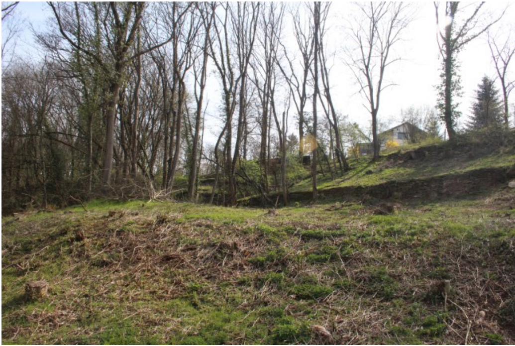
Abbildung 4: Stützmauern und Waldbereich im mittleren Eingriffsbereich
