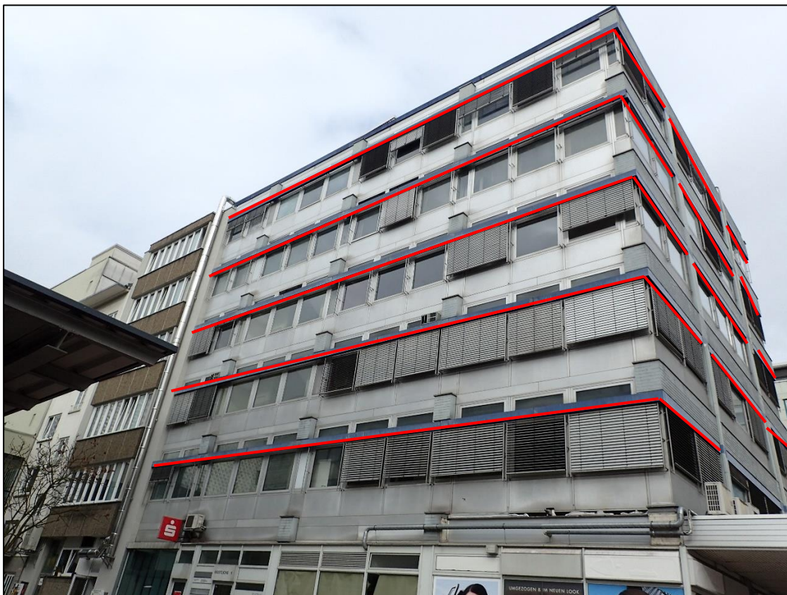
Abbildung 3: Süd- und Ostseite des Gebäudes mit zahlreichen Jalousiekästen mit unzureichender Eignung für gebäudebewohnende Fledermäuse (rote Markierungen).
