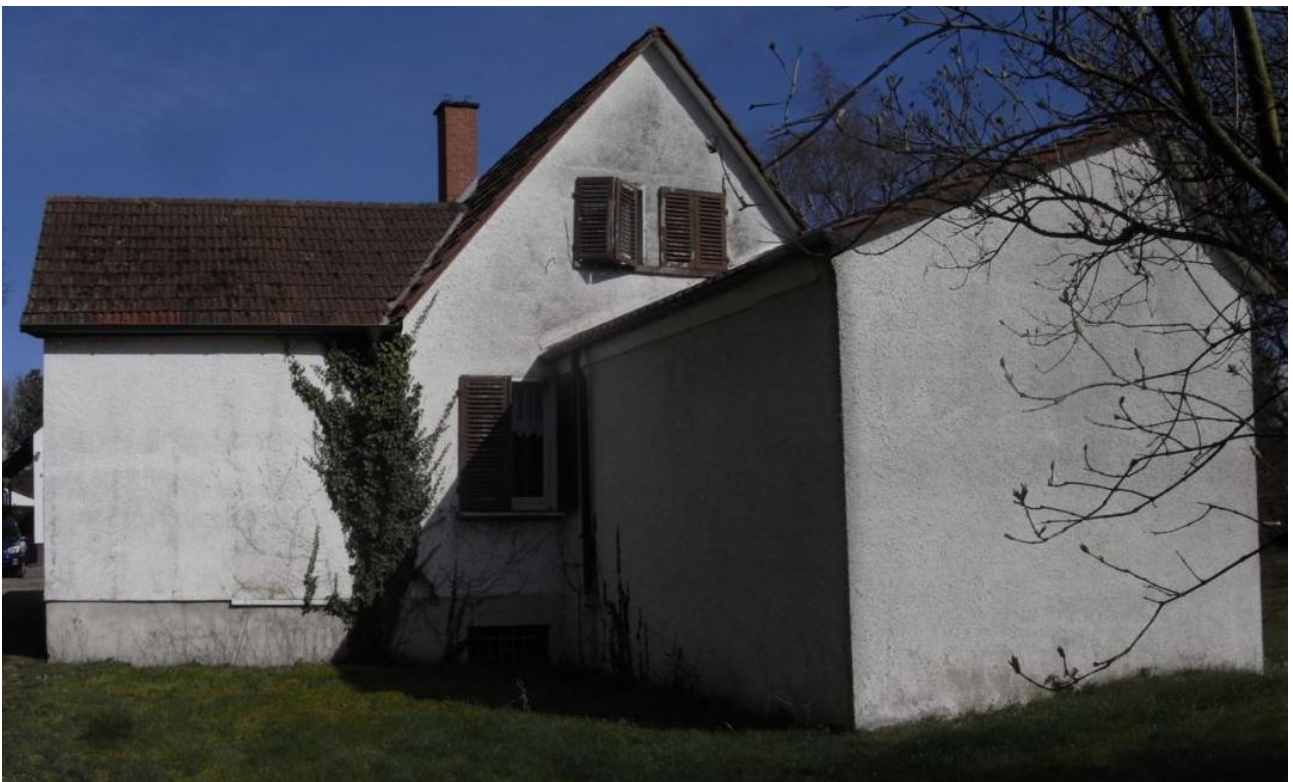
Abb. 7: Blick auf die Rückseite von Haus Nr. 26
