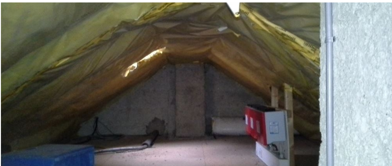
Abb. 16: Vollständig isolierter Dachstuhl von Gebäude Nr. 24 ohne Spuren einer Nutzung durch Fledermäuse
