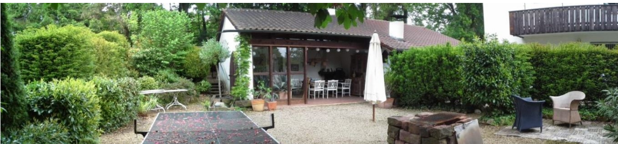
Abb. 9: Anbau zu Haus Nr. 24 mit umgebenden Zierhecken und Sitzgelegenheiten
