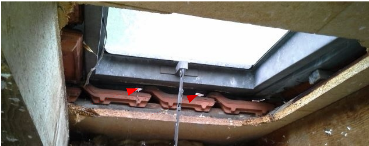
Abb. 18: Gebäude Nr. 22: Zugänge zum Dachstuhl durch Hohlräume zwischen Dachziegeln und Dachfensterrahmen (Pfeile)
