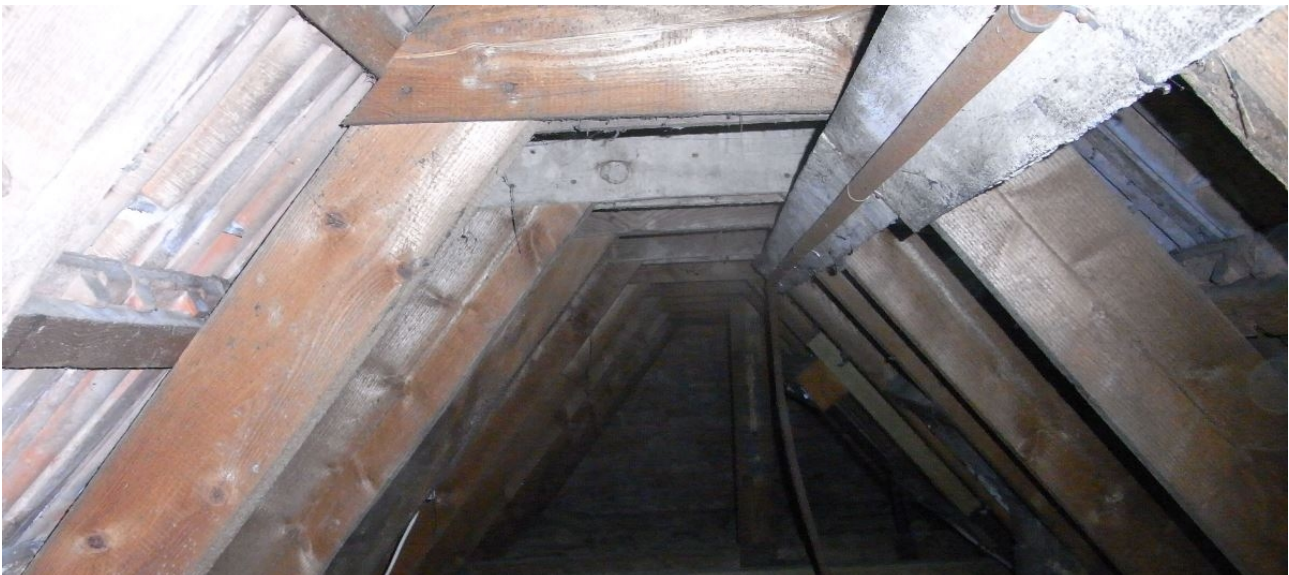
Abb. 15: Dachstuhlbereich des Hauses Nr. 26 ohne Spuren von Fledermäusen
