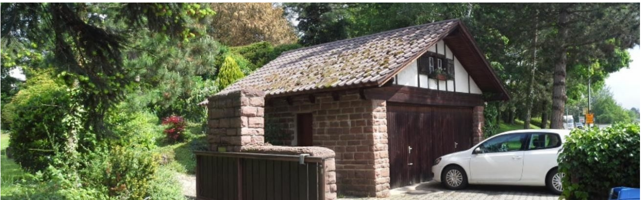
Abb. 12: Garage im Südosten von Flurstück Nr. 16657/2
