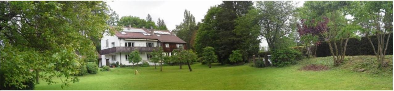
Abb. 11: Blick auf das Gebäude Nr. 22 und 24 von Südwesten aus.
