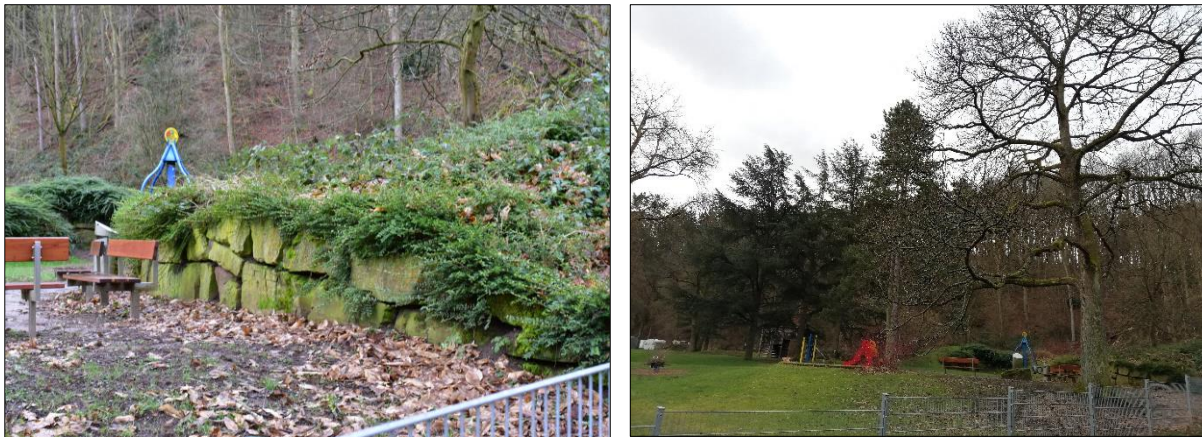
Abbildung 6: Stark bewachsene und bemoste Steinmauer (linkes Bild) sowie kurzrasige Grünfläche des Spielplatzes (rechtes Bild).
