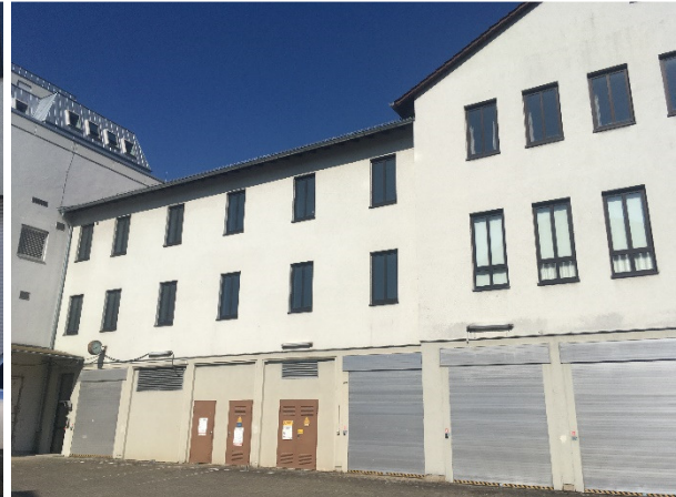
Südfrent des Abrissgebäudes; das am linken Bildrand angrenzende Gebäude bleibt erhalten
