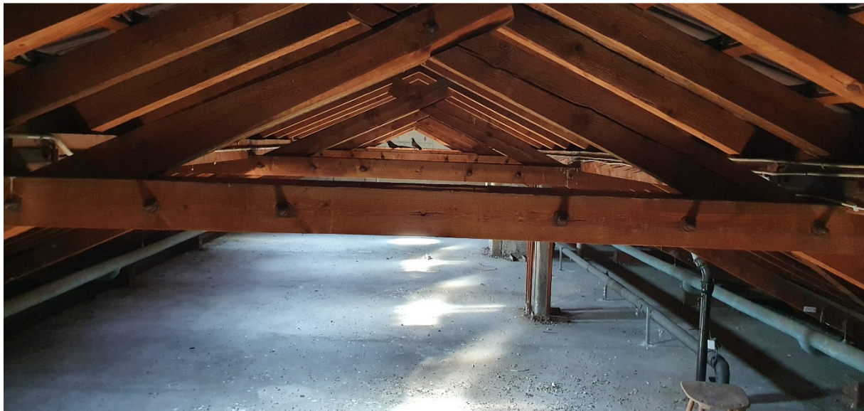
Dachstuhl des Westflügels mit Straßentauben
