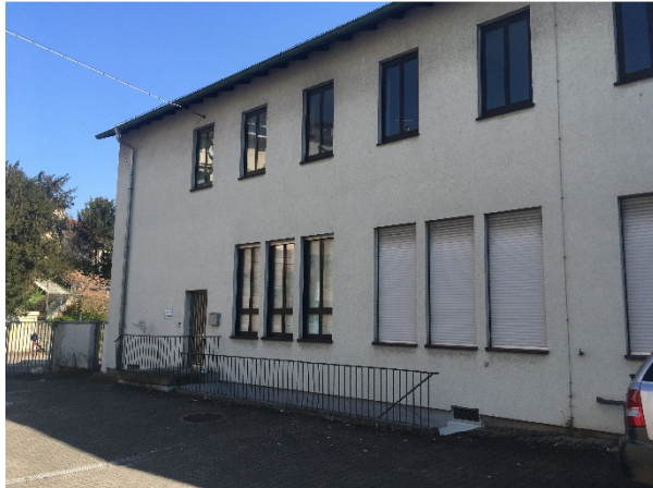
Ostflügel vom Hof aus gesehen mit Blickrichtung Nordost
