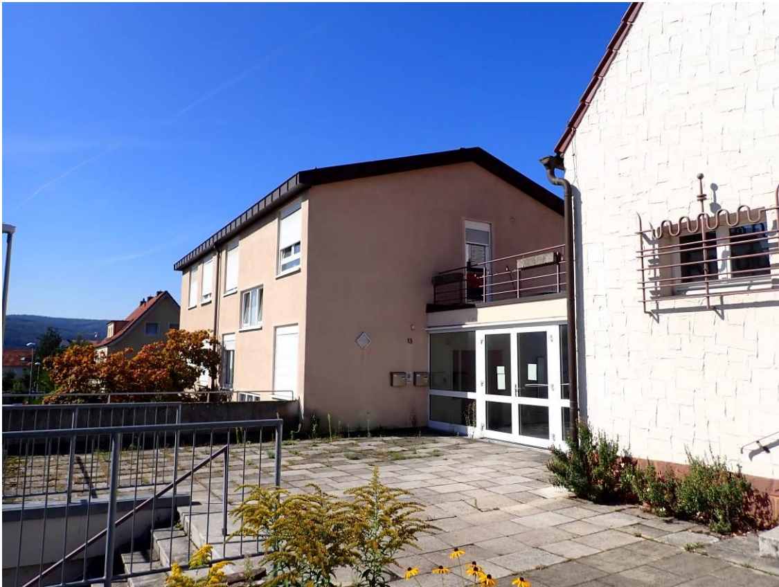
Abb. 21: Übergang Gebäude C und D auch hier ohne Nachweis der Mehlschwalbe aber vom Haussperling und Mauersegler.
