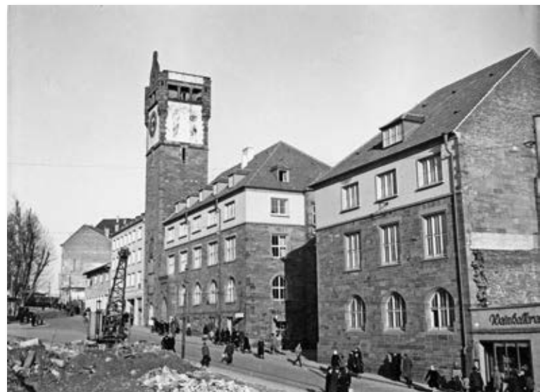
Abb. 6: Wiederaufbau des Bezirksamtsgebäudes ca. 1950 (Stadtarchiv Pforzheim, S1-08-B-004-V-041, Foto: Hermann Meyer)
