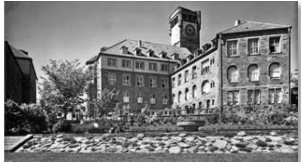
Abb. 2: Bezirksamtsgebäude 1952 (Stadtarchiv Pforzheim, S1-06-104-V-026, Foto: Gebrüder Metz)
