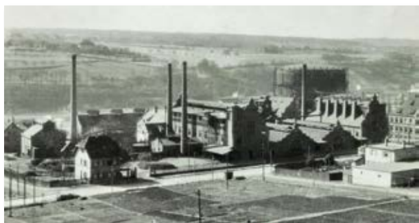
Blick auf das Gaswerk an der Eutinger Straße 1930 (B81-266; Foto: Stadtwerke Pforzheim)
