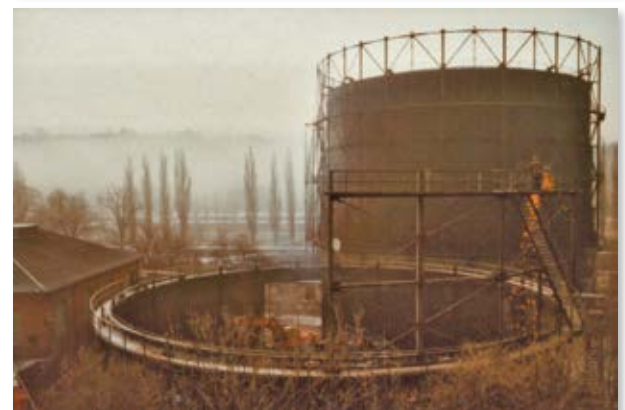
Abbruch des Gasbehälters IV im Dezember 1983 (B81-270; Fotos: Stadtwerke Pforzheim)
