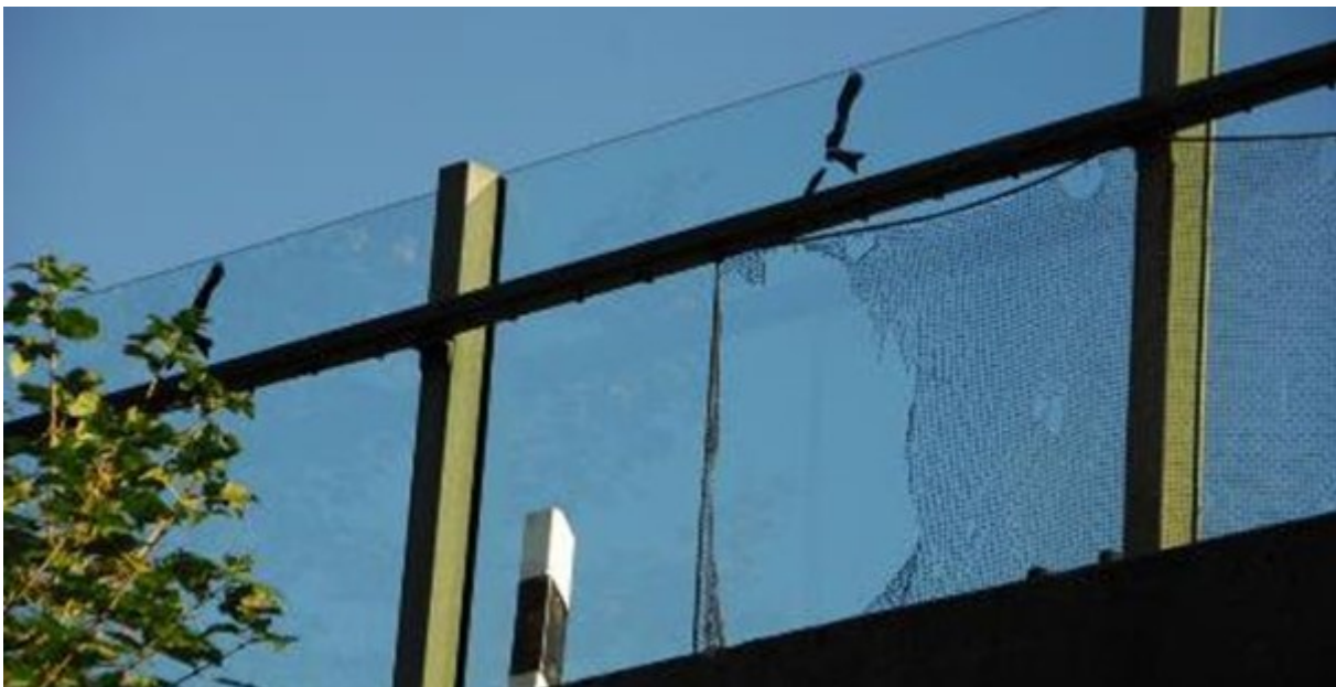
Abb. 7: Gläserne Lärmschutzwand auf einer Brücke. Ein paar Silhouetten und ein beschädigtes Netz verhindern Vogelkollisionen nicht (B.-U. Rudolph)
