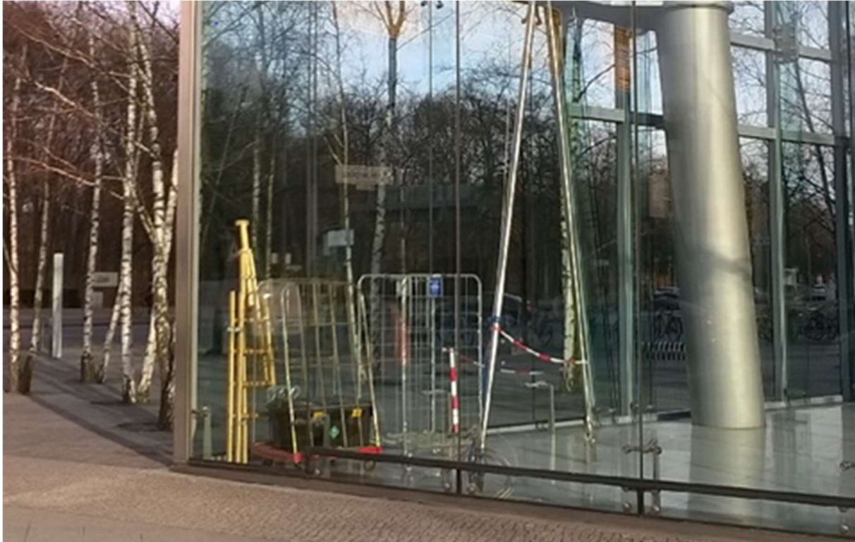
Abb. 10: Spiegelnde Eckverglasung an einem Verwaltungsgebäude; Vogelverluste sind hier nachgewiesen (K. Steiof)
