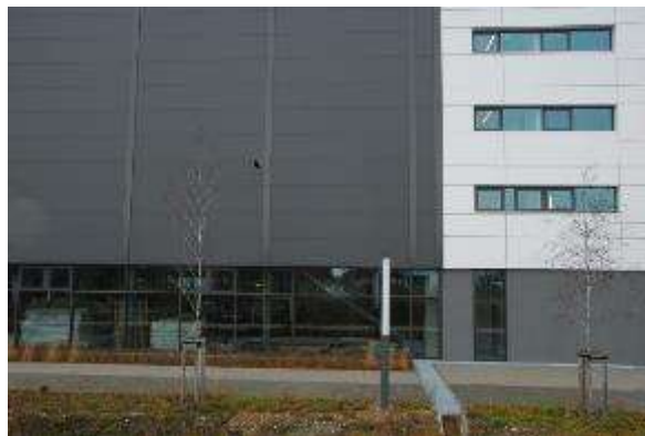
Abb. 20: Die Fassaden sollten zur Bewertung in homogene Abschnitte unterteilt werden (B.-U. Rudolph)
