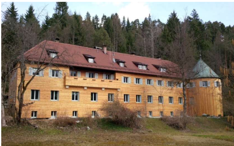
Garmisch-Partenkirchen, Staatliche Vogelschutzwarte (B.-U. Rudolph)
