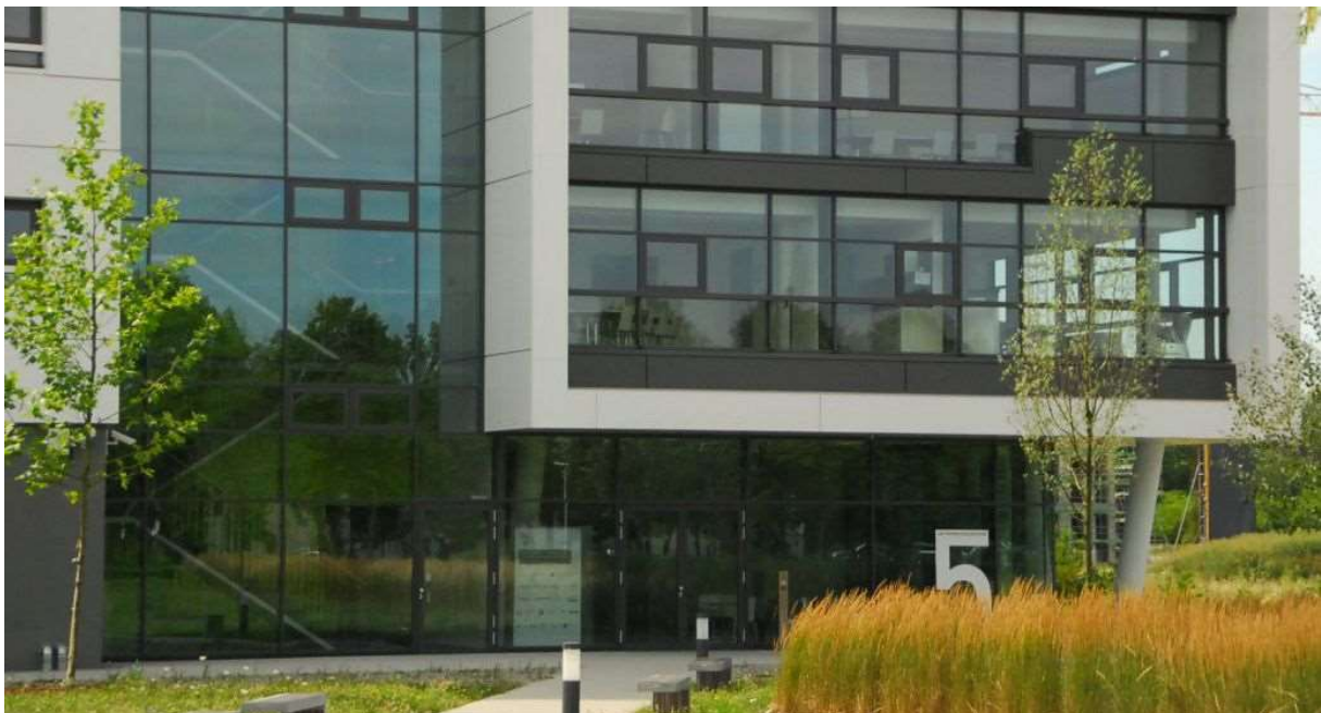
Abb. 9: Mit der Größe der Glasfassade steigt das Risiko des Vogelschlags; Vogelverluste sind hier nachgewiesen (B.-U. Rudolph).
