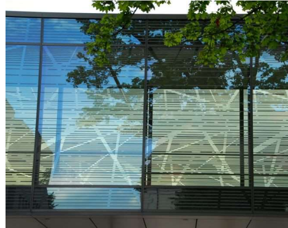
Abb. 4: Für Mensch und Vogel wirksam markierter Übergang zwischen zwei Gebäuden eines Krankenhauses (B.-U. Rudolph)
