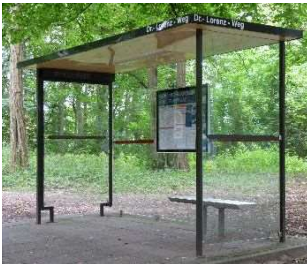
Abb. 17: Wartehäuschen in einer waldähnlichen Grünanlage, Vogelverluste sind hier nachgewiesen (J. Bellebaum).
