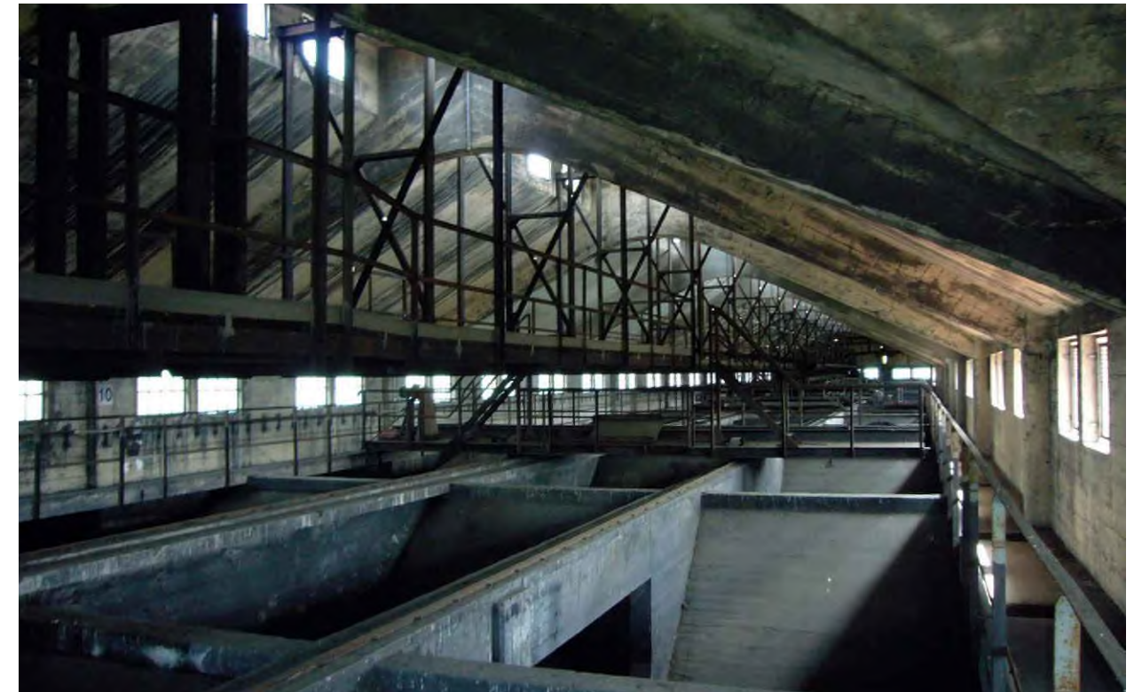
Abb. 52.: Kohlebunker Dachstuhl © Stadt Pforzheim
