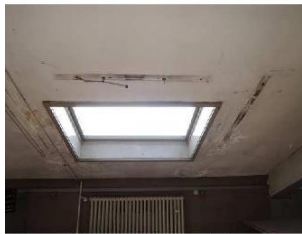
DG; Raum D 5, Wasserschaden 084070-000-00487-000_073.JPG 2017.06.13 10:26:53
